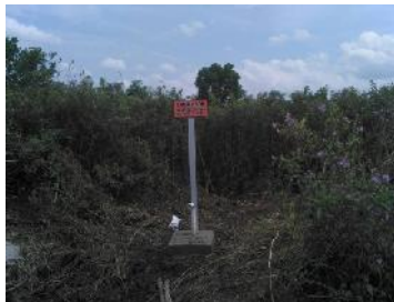
Gambar 49. Pengecoran Sumur Bor Dan Pemasangan Plang
