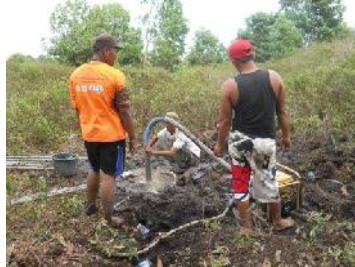
Gambar 40. Pada Kedalaman 27 Meter Tim Sudah Menemukan Pasir Halus Dan Sumber Air Yang Keluar
