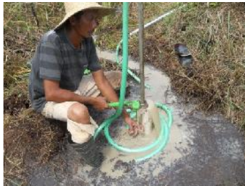
Gambar 73. Proses Pengeboran Sumur
