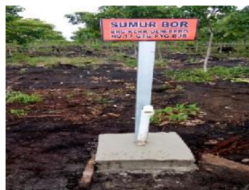
Gambar 103. Pengecoran Sumur Bor Dan Pemasangan Plang Penomoran
