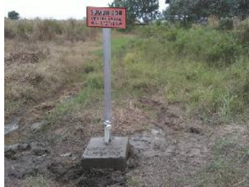
Gambar 17. Pengecoran Dan Pemasangan Plang Penomoran Sumur Bor
