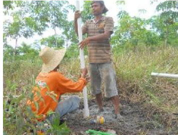
Gambar 68. Pemasangan Pipa Paralon
