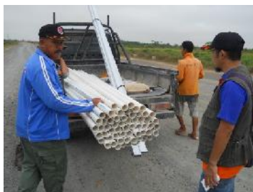
Gambar 8. Penurunan Bahan Pembuatan Sumur Bor
