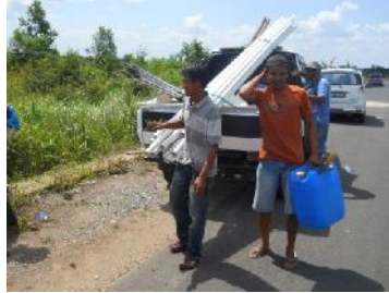
Gambar 1. Penurunan Bahan Pembuatan Sumur Bor
