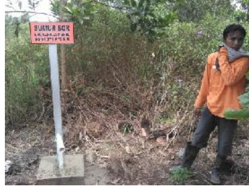
Gambar 24. Pengecoran dan Pemasangan Plang
