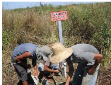
Gambar 61. Pengecoran Sumur Bor Dan Pemasangan Plang Penomoran
