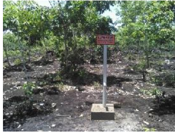
Gambar 96. Pengecoran Sumur Bor Dan Pemasangan Plang Penomoran
