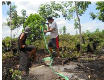
Gambar 66. Tim Pekerja Sumur Bor Melakukan Pengeboran
