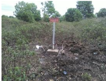
Gambar 30. Pengecoran dan pemasangan plang penomoran sumur bor
