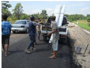
Gambar 31. Tim Pembuat Sumur Menurunkan Peralatan
