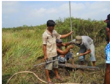
Gambar 29. Pengeboran Kedalaman 20 meter
