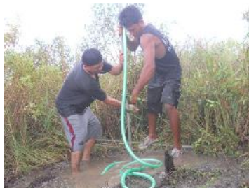
Gambar 62. Pengeboran Di Titik Yang Sudah Ditentukan
