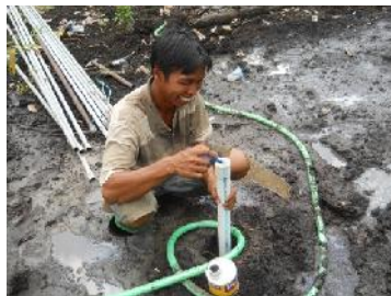
Gambar 94. Pengeleman Pipa Paralon
