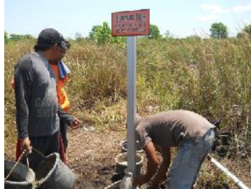
Gambar 88. Pengecoran Sumur Bor Dan Pemasangan Plang
