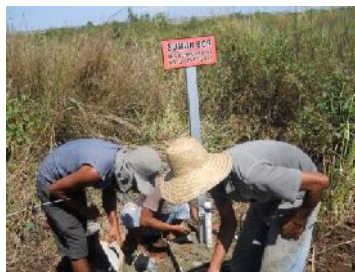
Gambar 70. Pengecoran Sumur Dan Pemasangan Plang Penomoran Sumur
