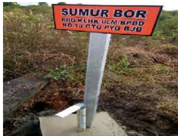
Gambar 110. Pengecoran dan Penomoran
