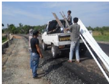
Gambar 13. Penurunan Bahan Pembuatan Sumur Bor
