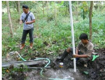
Gambar 53. Pemasangan Pipa Paralon
