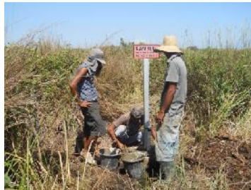
Gambar 76. Pengecoran Sumur Bor Dan Pemasangan Plang Penomoran
