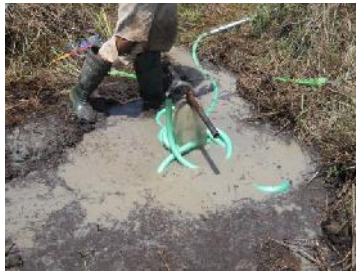
Gambar 74. Pengeboran Pada Kedalaman 24 Meter
