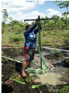
Gambar 99. Persiapan Untuk Memasukkan Alat Bor
