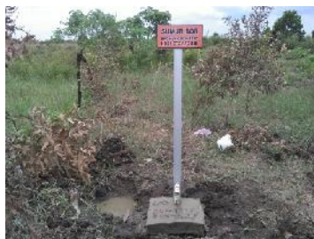
Gambar 35. Pengecoran Sumur Bor Dan Pemasangan Plang Penomoran
