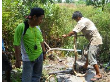
Gambar 47. Pada Kedalaman 27 Meter Ditemukan Pasir dan Sumber Air
