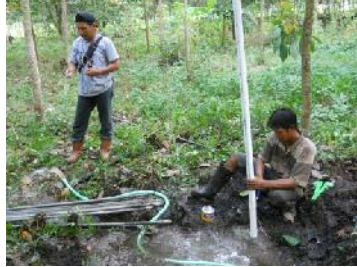
Gambar 79. Pemasangan Pipa Paralon
