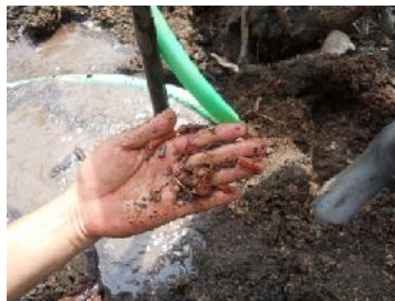
Gambar 67. Proses Pengeboran Dilapisan 10 Meter
