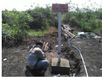
Gambar 7. Pengecoran Sumur Bor Dan Pemasangan Plang Penomoran
