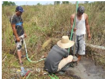
Gambar 113. Persiapan Untuk Memasukkan Alat Bor
