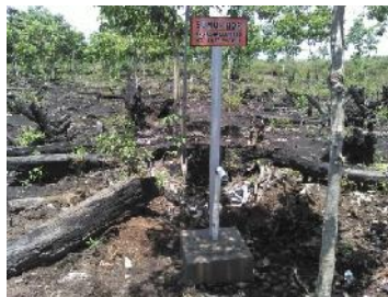
Gambar 81. Pengecoran Sumur Bor Dan Pemasangan Plang Penomoran
