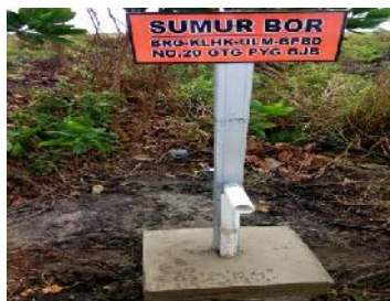
Gambar 124. Pengecoran dan Pemasangan Plang
