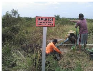
Gambar 12. Pengecoran Sumur Bor Dan Pemasangan Plang Penomoran
