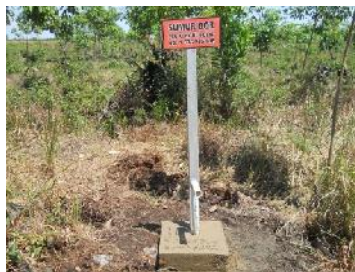
Gambar 65. Pengecoran Sumur Bor Dan Pemasangan Plang Penomoran
