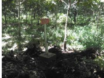
Gambar 55. Pengecoran Sumur Bor Dan Pemasangan Plang Penomoran
