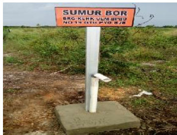
Gambar 117. Pengecoran Dan Pemasangan Plang
