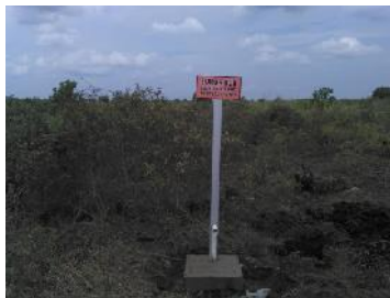
Gambar 42. Pengecoran Sumur Bor Dan Pemasangan Plang Penomoran
