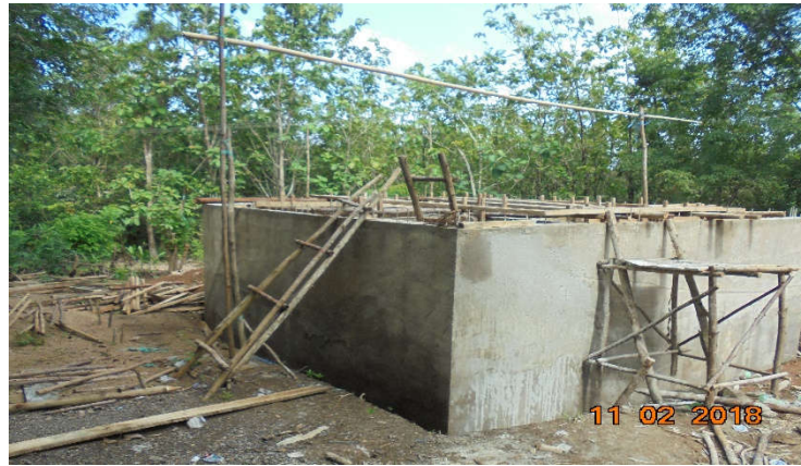
(Gambar 4.4 Proses Pembangunan Sumber Air Bersih)
