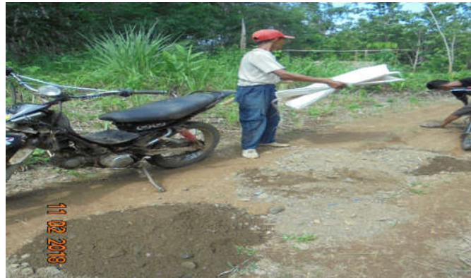
(Gambar 4.7 proses pengerasan jalan menuju ke kebun)
