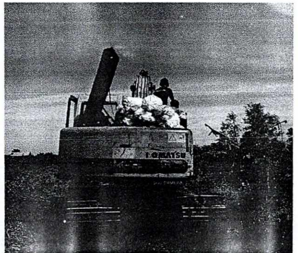
Gambar 30. Pekerjaan Pengisian Tubuh Sekat dengan Karung Berisi Tanah
