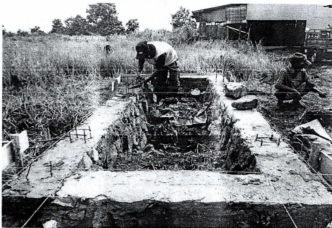
Gambar 47. Proses Pengerjaan Tempat Meletakkan Instalasi Penjernih Air
