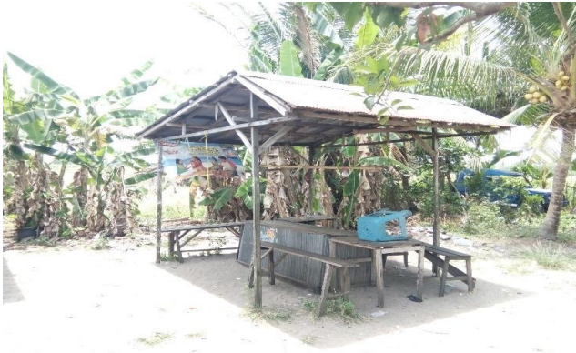
Gambar 10. 5. Kantin yang Ada di SDN Pematang Panjang
